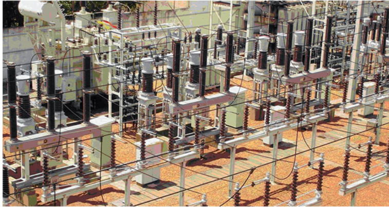
Fig 1. Estación transformadora de alta tensión
